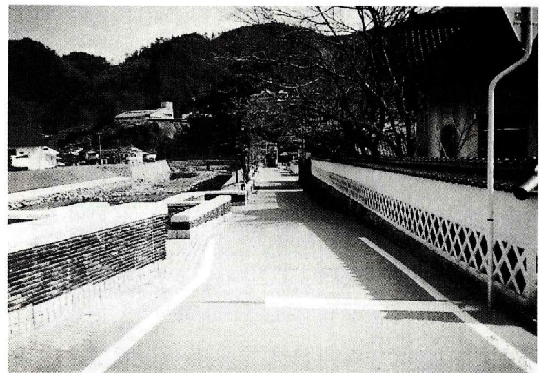
楽しく散策できる護岸道路の整備
