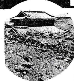
土石流に埋まった民家（深江町）
